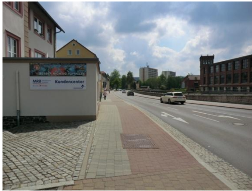
Abb. 88: M37 ZTR bei Seeberbrücke Ost
