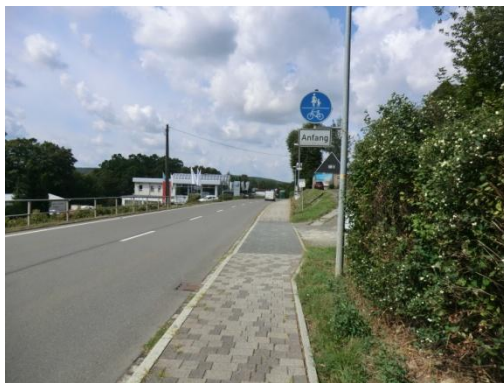
Abb. 84: M31 Dresdner Str. bei Tankstelle
