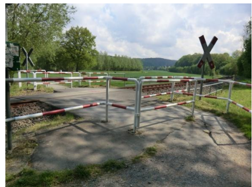
Abb. 103: M65 FTR östl. Bahnquerung
