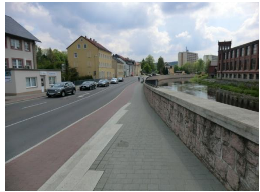
Abb. 89: M38 ZTR bei Seeberbrücke West
