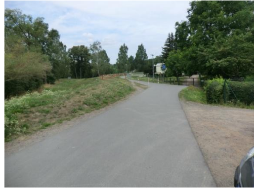
Abb. 73: M15 ZTR bei Ortsumfahrung
